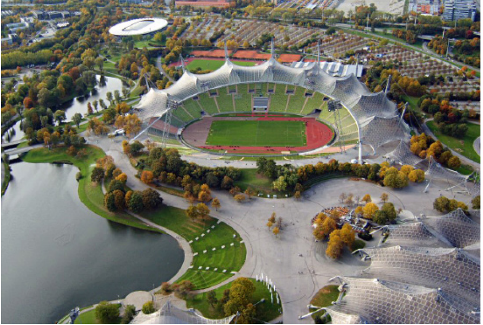
Abb. 4: Das Olympiagelände 1972 in München mit den Spannzelten aus Plexiglas; Foto: Wikimedia Commons, Radox (CC BY-SA 3.0).
