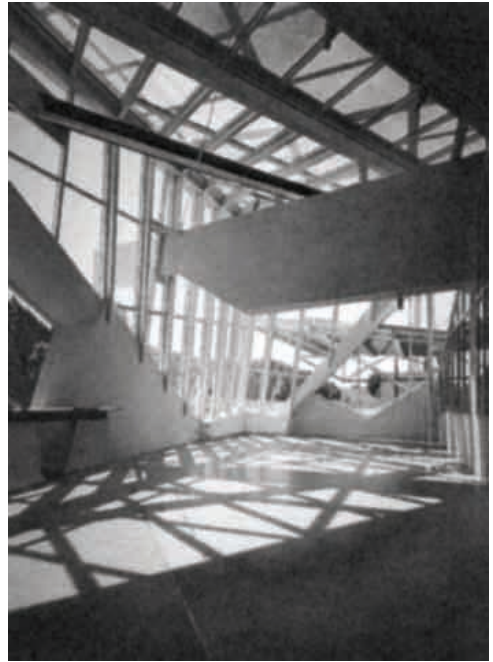
Abb. 75 Coop Himmelblau, Funderwerk 3, Aufgekanteter Eckraum, heute Ausstellungsraum
